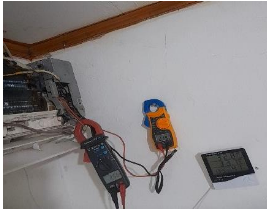
Gambar 5. Pengukuran Arus, Tegangan, dan Suhu
