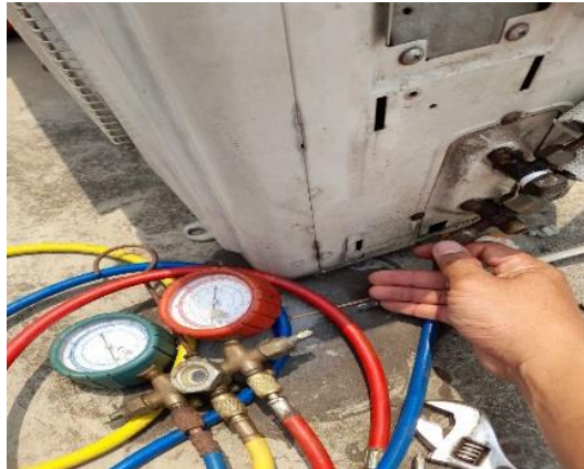
Gambar 2. Pengukuran Tekanan
