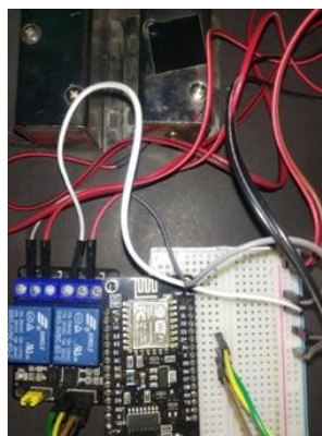
Gambar 6. Pemasangan Solenoid Doorlock pada Relay
