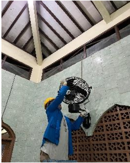
Gambar 2. Proses Pemasangan Kipas Angin Turbo dan Perapihan Kabel oleh Tim
