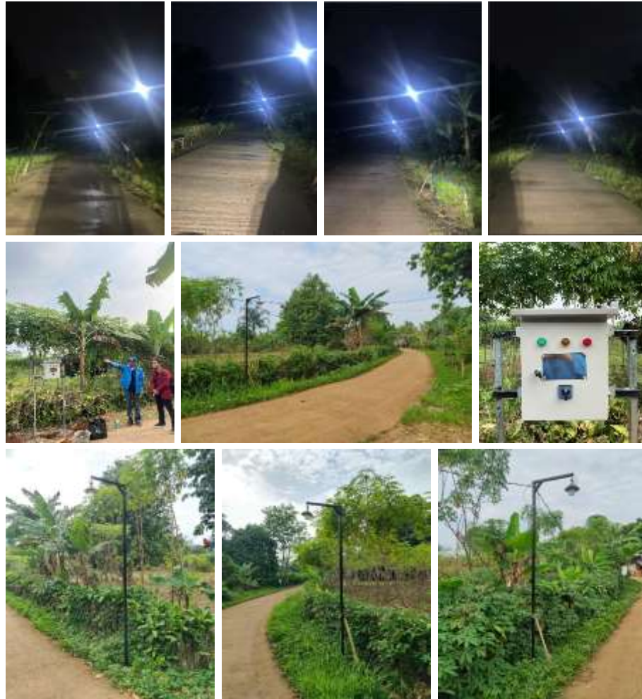
Gambar 6. Hasil Pemasangan dan Pengujian Sistem PJU Otomatis
