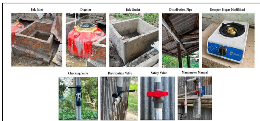
Gambar 1. Komponen Utama Biogas
