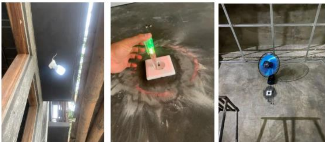
Gambar 6. Pengetesan Intalasi Listrik
