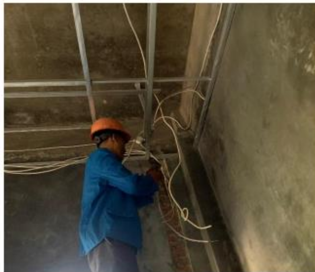
Gambar 4. Penerapan Jalur Kabel
