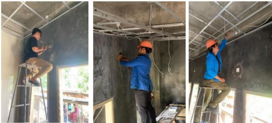
Gambar 5. Saklar, Stop Kontak, Kipas Angin dan Lampu
