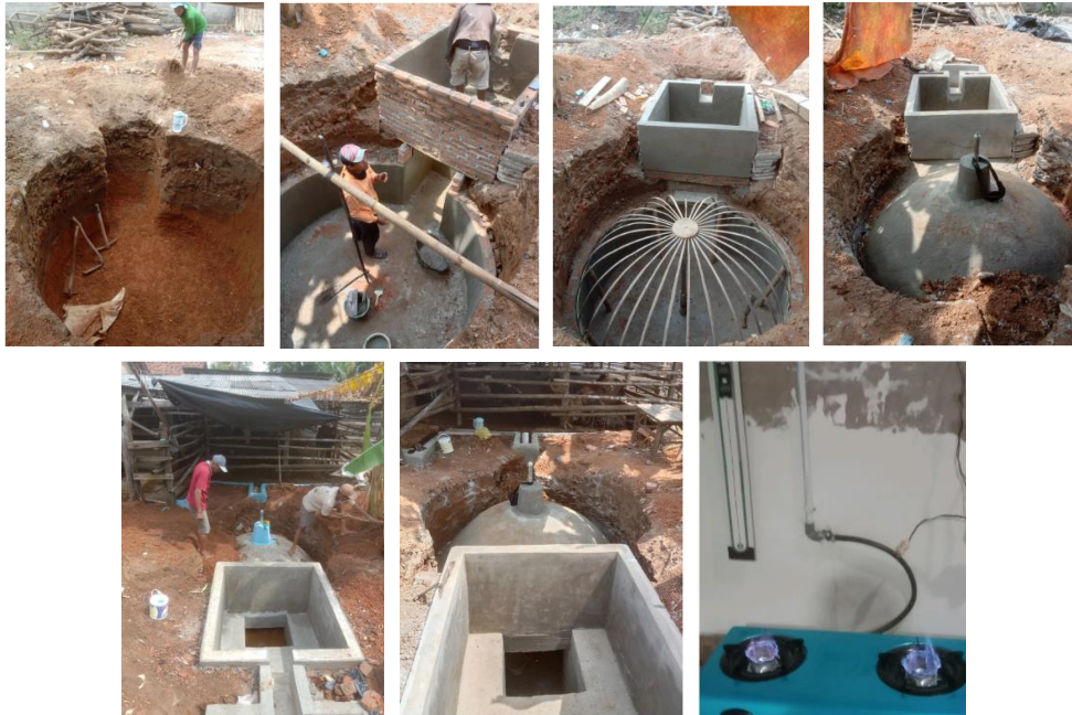
Gambar 6. Dokumentasi Pembangunan Instalasi Biogas
