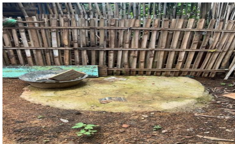
Gambar 12. Bangunan SPAL di Rumah Bapak Ngabidun Kampung Pujo Kerto
