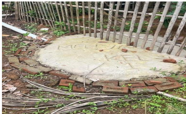
Gambar 6. Bangunan SPAL di Rumah Bapak Arshad Kampung Pujo Kerto
