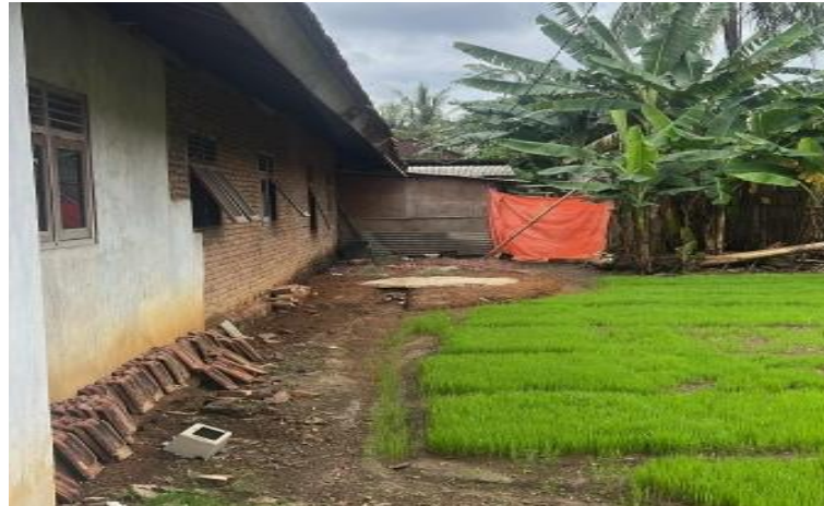
Gambar 13. Bangunan SPAL di Rumah Bapak Zakaria Kampung Pujo Kerto
