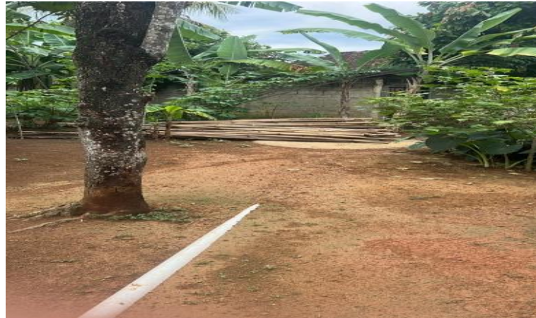
Gambar 10. Bangunan SPAL di Rumah Bapak Kusnandar Kampung Pujo Kerto
