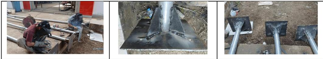
**Gambar 4.** Pembuatan Dudukan Tiang Lampu PJU
