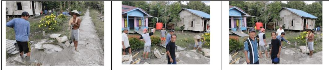
**Gambar 3.** Pembuatan Pondasi Tiang Lampu PJU
