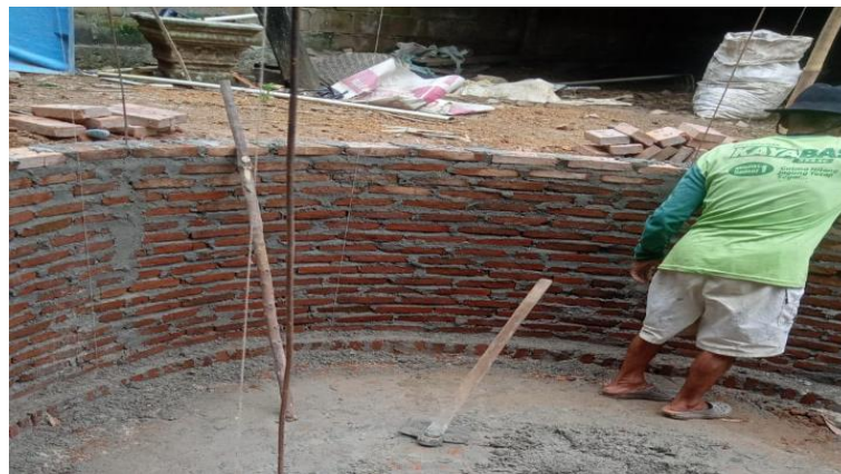
Gambar 3. Pemasangan Bata Keliling Biogas
