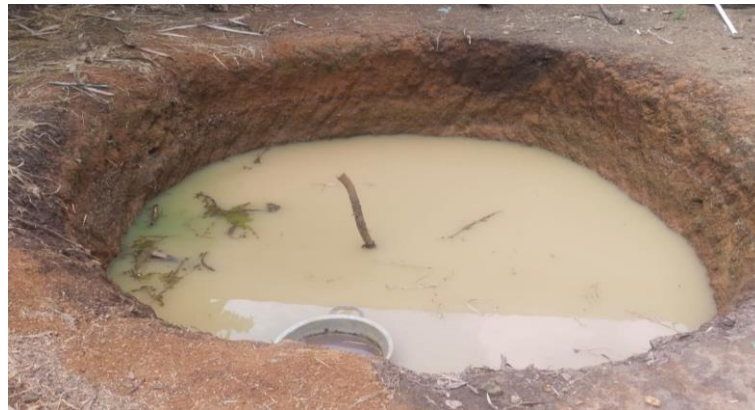
Gambar 2. Pembuatan Lubang Biogas
