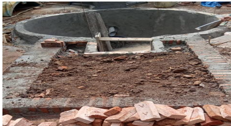
Gambar 5. Pembuatan Pondasi Bak Outlet
