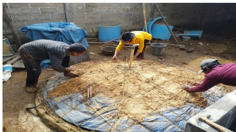
Gambar 9. Pembuatan tulangan Kubah Digester
