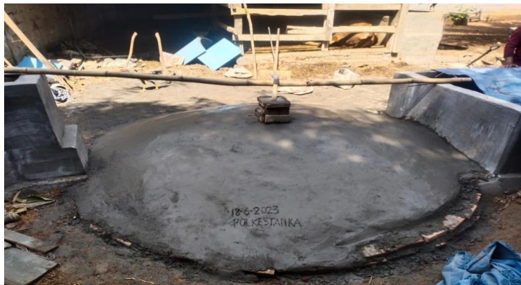
Gambar 10. Pengecoran Kubah Digester
