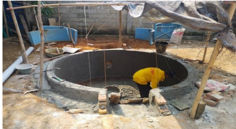
Gambar 4. Pemasangan Plester Pada Digester
