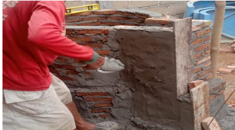
Gambar 7. Pembuatan Bak Inlet
