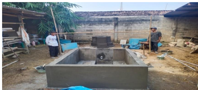
Gambar 6. Pemasangan Plester Bak Outlet
