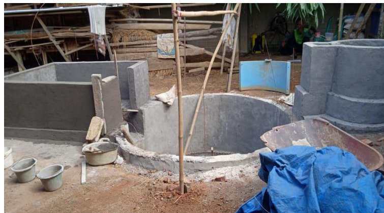
Gambar 8. Bangunan Biogas Tampak Samping
