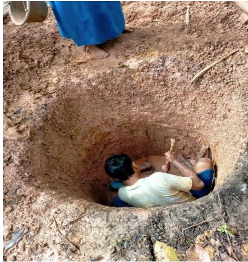
Gambar 8. Pembuatan Lubang SPAL
