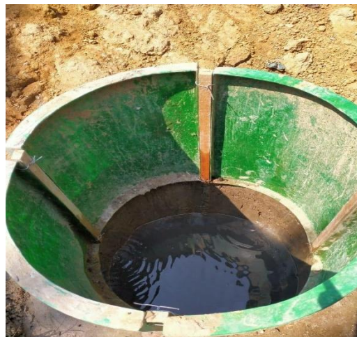
Gambar 9. Pencetakan Dinding Lubang SPAL
