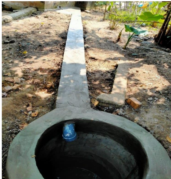
Gambar 12. Saluran Dari Kamar Mandi Menuju SPAL
