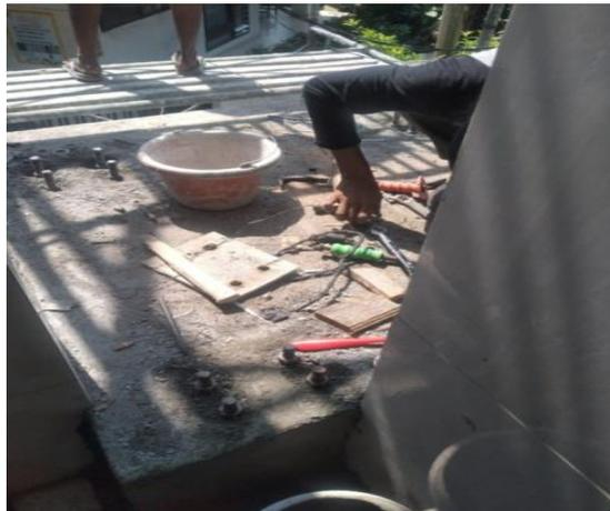
**Gambar 7.** Pemasangan Stek Dan Cor Balok.
