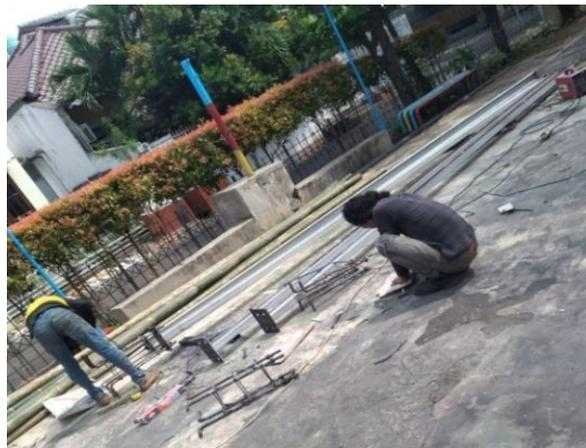
**Gambar 5.** Fabrikasi Rangka Utama Minaret.
