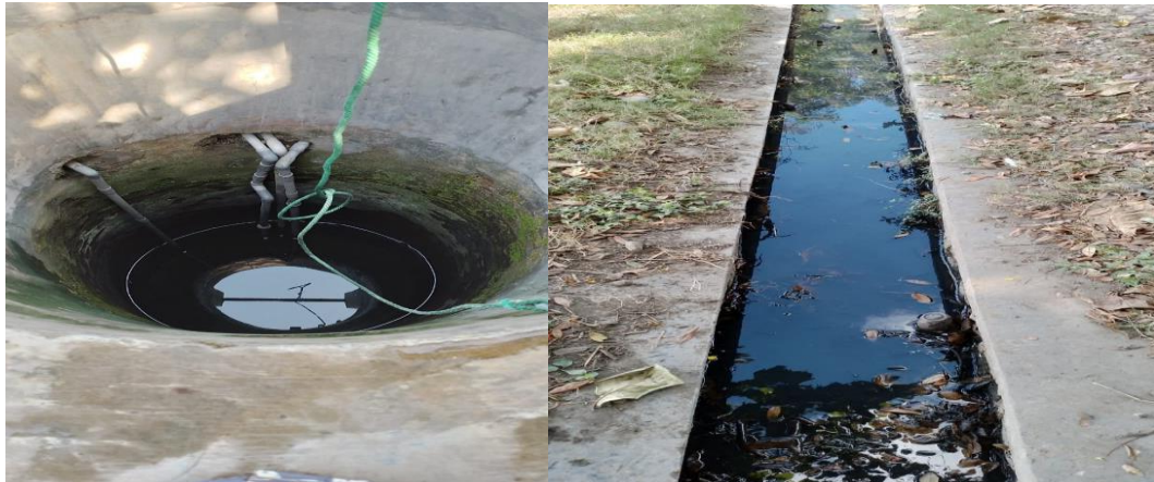
Gambar 3. Pemantauan Jentik Nyamuk pada Sumur dan Selokan
