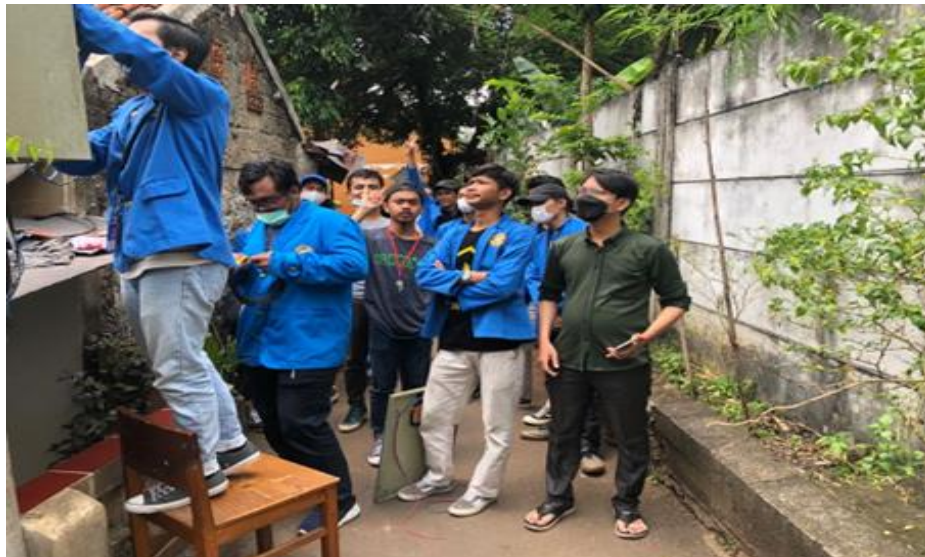
Gambar 4. Pemasangan panel kontrol otomatis lampu PJU.
