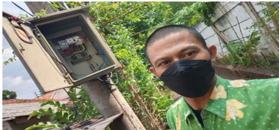
Gambar 6. Pengetesan panel kontrol otomatis lampu PJU.
