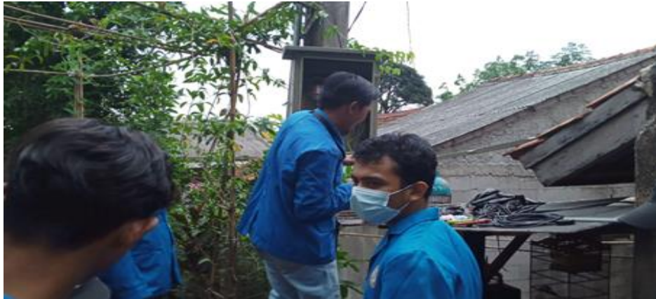
Gambar 5. Penyambungan rangkaian lampu PJU.
