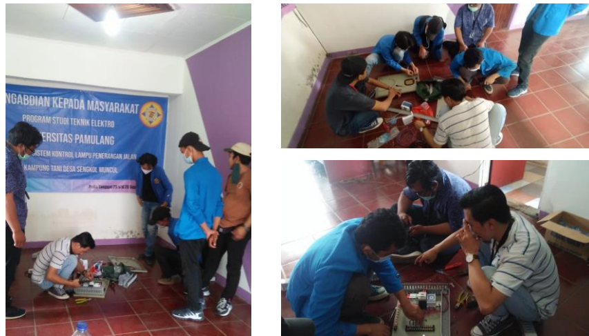
Gambar 3. Perakitan panel kontrol otomatis lampu PJU.
