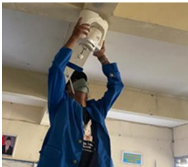
Gambar 14. Pemasangan fan rotari.
