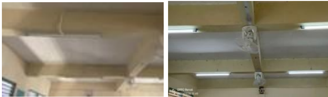
Gambar 16. Hasil pemasangan instalasi (a) sebelum diuji dan (b) setelah diuji lampu penerangan
