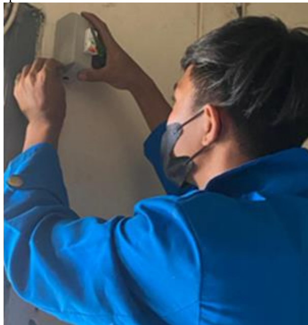
Gambar 11. Pemasangan sistem proteksi instalasi.
