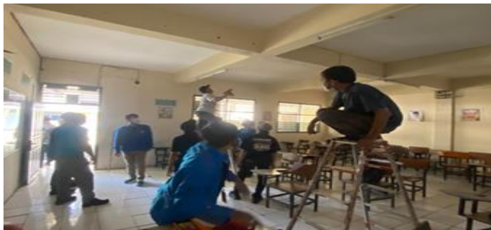
Gambar 13. Pemasangan lampu penerangan.
