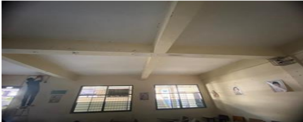
Gambar 12. Pemasangan instalasi kabel.
