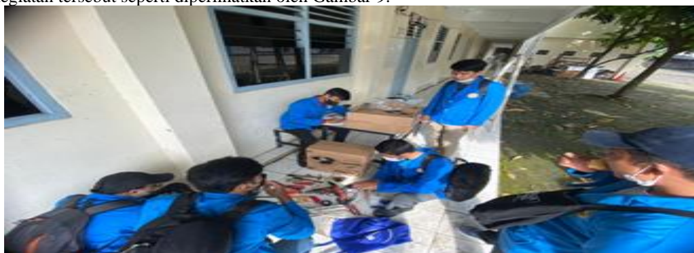
Gambar 9. Perakitan lampu penerangan dan sistem distribusi udara.
