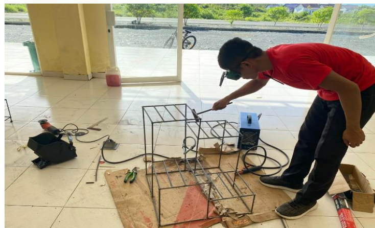
Gambar 15. Pengecekan hasil las
